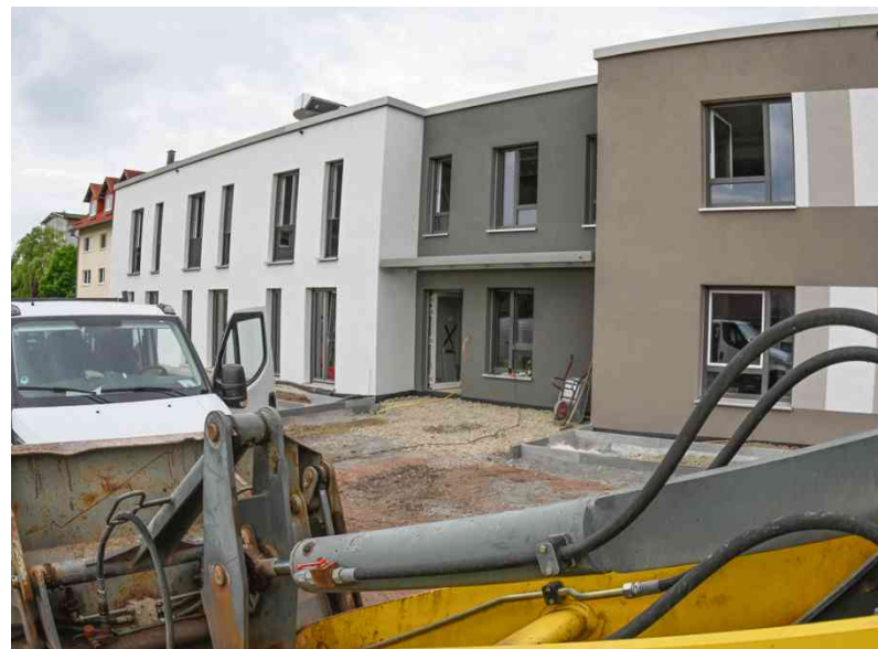
Von außen hat das Gebäude bereits Form angenommen. Das Gebäude ist voll klimatisiert und komplett barrierefrei angelegt.
